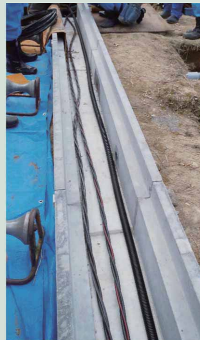
小型ボックスの試験施工（見附市）
